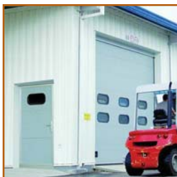
Dveře ve fasádě s průmyslovými sekčními vrata
